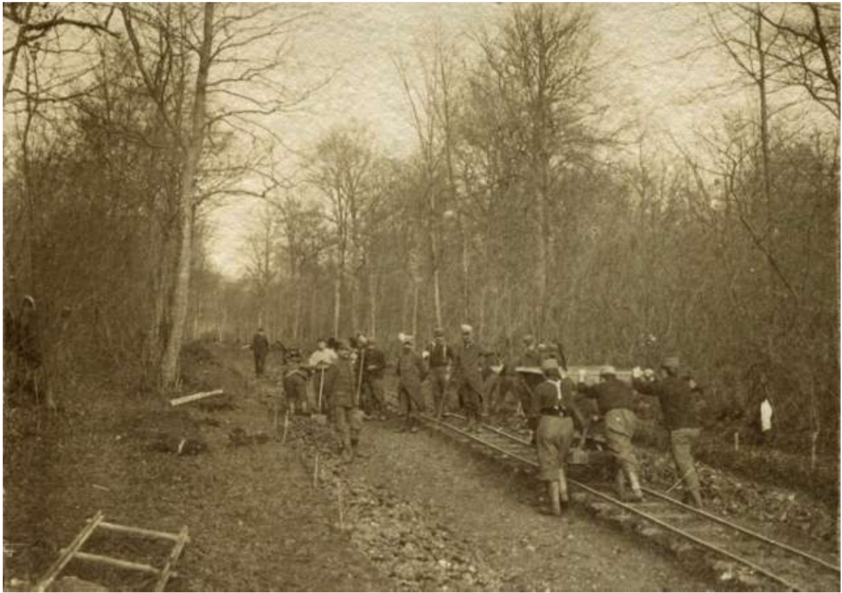
Un wagonnet circule sur le Decauville.
