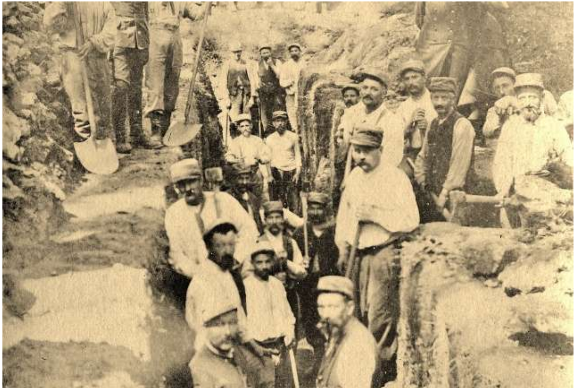
Les territoriaux participent aussi à l'aménagement de tranchées.
