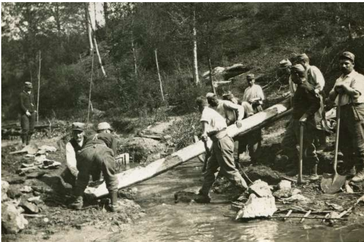
Construction d'un pont de fortune
