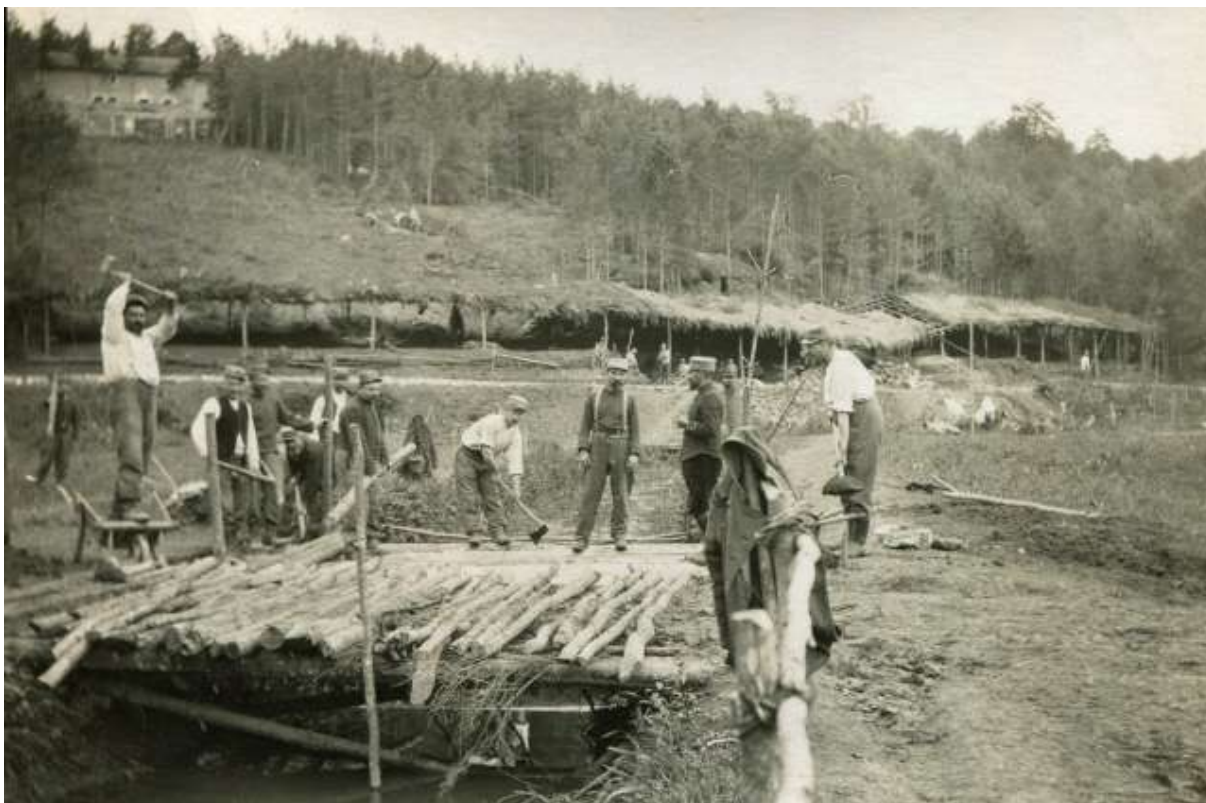
Mise en place d'un pont de secours
