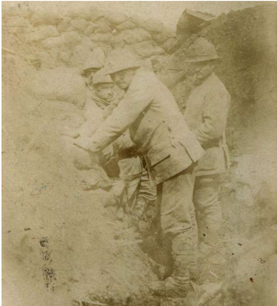
Fortin F – 17 h 30 – Consolidation de l'entrée de l'abri et du poste de guetteur avec des sacs remplis de la terre qui comblait la tranchée.
