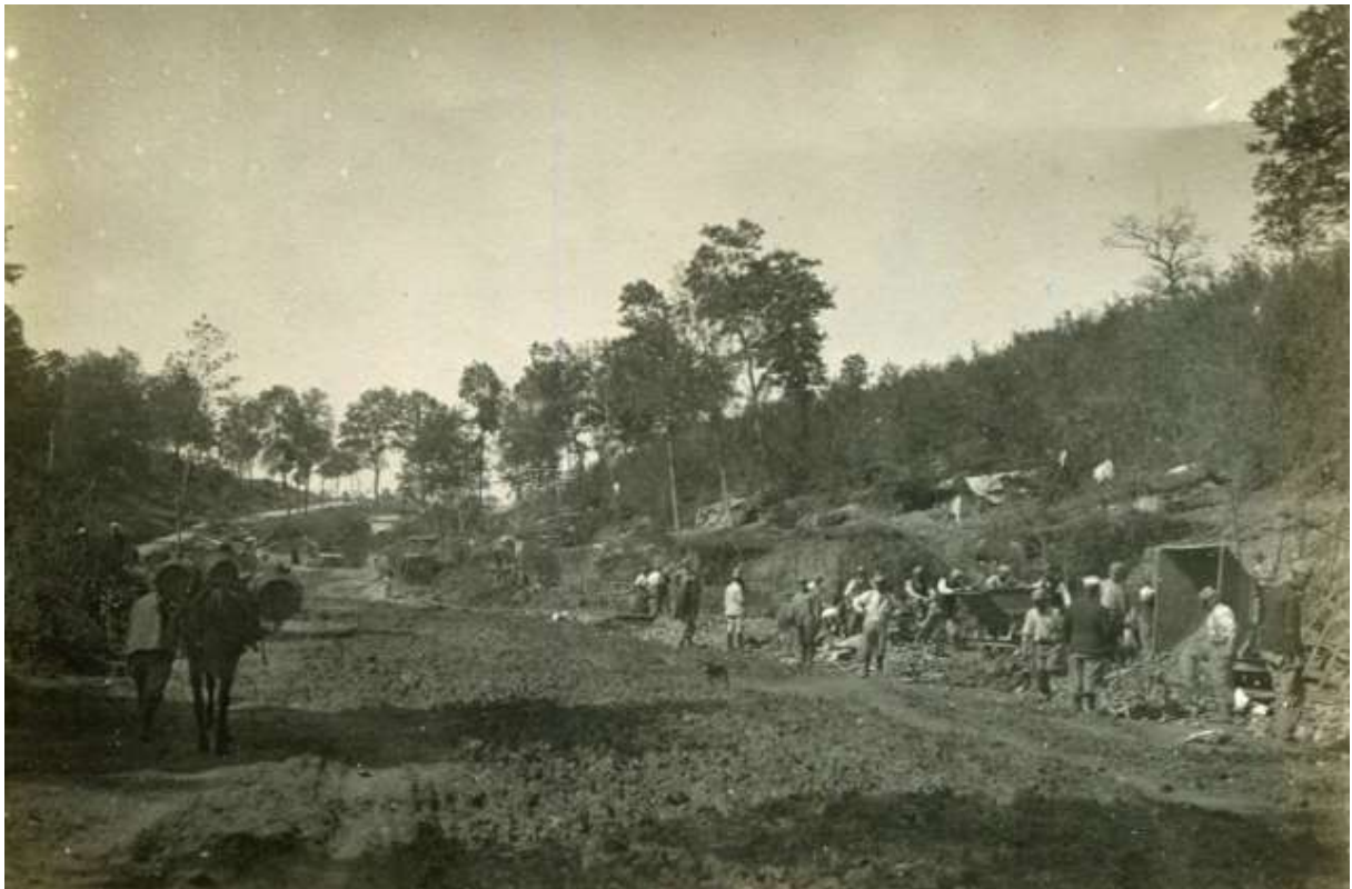
Les soldats procèdent à l'empierrement de l'emplacement de la future voie.
