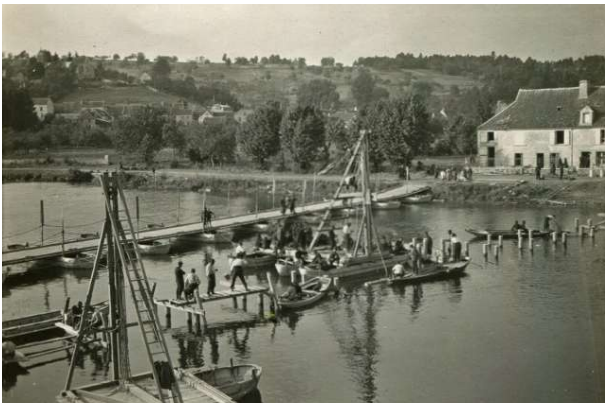
Mise en place d'un pont de bateaux
